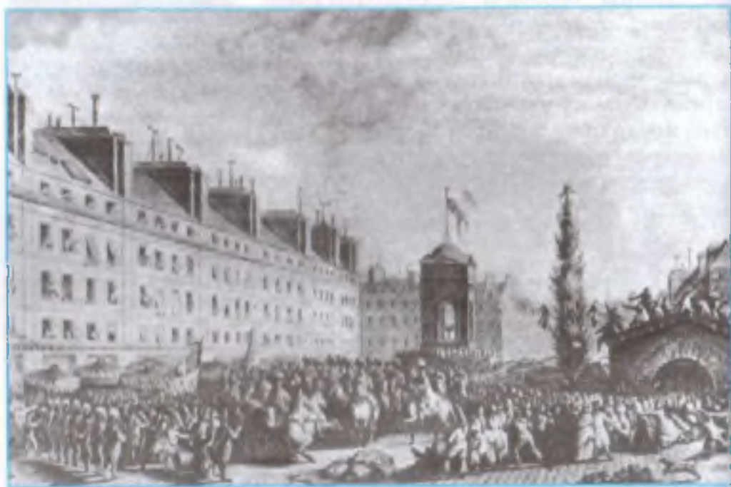
Франция. 18 сентября 1791 г. Провозглашение Конституции
