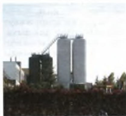
Рис. 75. Перегонка жидкого воздуха: а — схема процесса; б — промышленная установка
