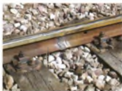
Рис. 42. Сваривание рельса алюминотермией (а); рельс, сваренный с использованием алюминотермии (б)
