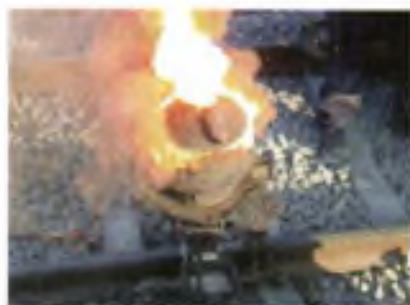
Рис. 42. Сваривание рельса алюминотермией (а); рельс, сваренный с использованием алюминотермии (б)
