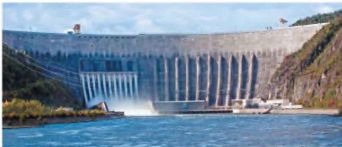
Рис. 37. Плотина Саяно-Шушенской ГЭС
