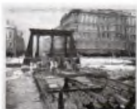
Разрушенный Египетский мост
